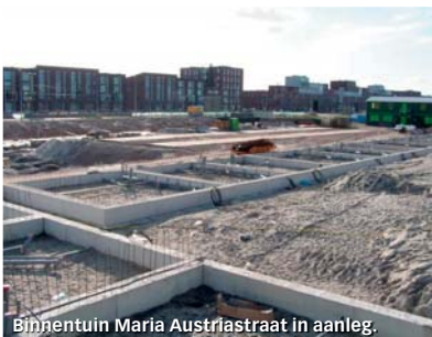
Binnentuin Maria Austriastraat in aanleg.
