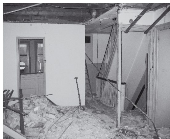
De huurster van deze woning in de Javastraat verwachtte slechts kleine werkzaamheden
