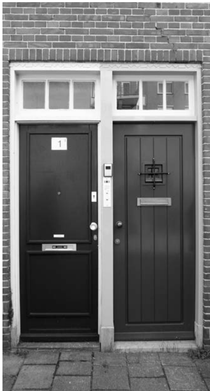
Voor en na de renovatie
